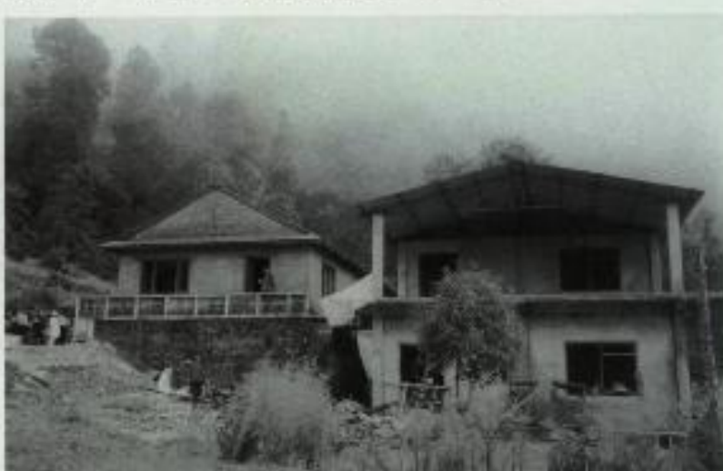
1990年に最後に建てられた管理棟(左)の隣りに現在建設中の科学実験室、図書室、診療所棟(右)3人の篤志家の寄付によるもの
