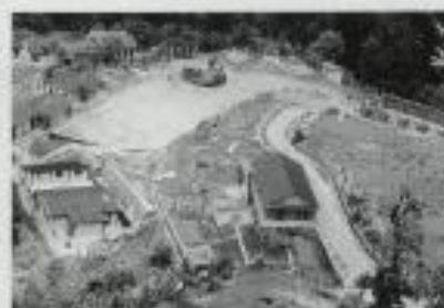
▲学校全貌（一九九八年五月撮影） ▲右上の方に建設中の講堂
