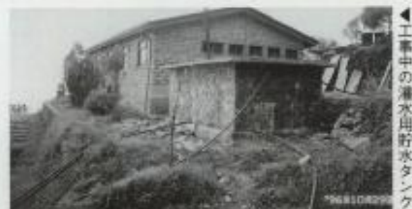
◀工事中の灌水用貯水タンク
