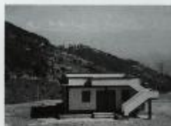
▲新設の研究調査員宿泊棟
