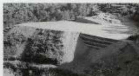
▲造成を終えた研究員宿泊棟建設地
