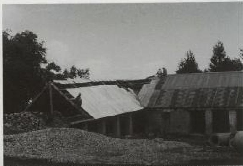
▲近藤愛子さん支援のラニパワの学校、建設中の写真で今は完成して使用しています
