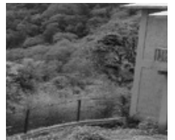
▲学校の周囲に堅ろうな柵が完成
