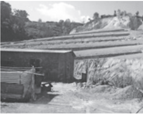
▲山肌を削り造成工事が進められているカトマンズ郊外
