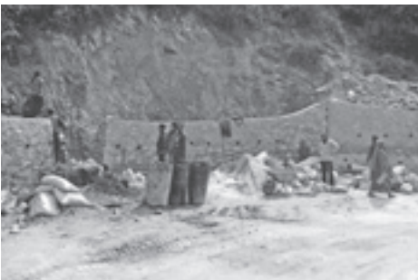
▲人海戦術で行われているカカニへ通ずる道路の拡幅工事
