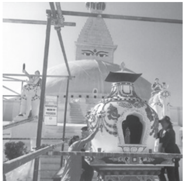
▲肅々と進むボダナートの修復
