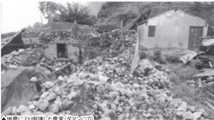
▲地震により倒壊した農家(ダマンにて)
