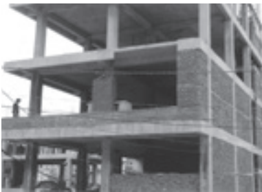
▲レンガを積み上げていく新築工事現場
