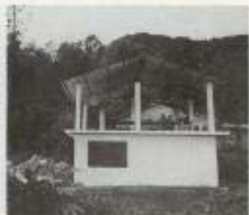
▶日本の車の販売業者により農場内に建設されたイチゴの集出荷調整施設「1階部分」2階は採果販売農園の集荷する予定で、とりあえず柱と屋根だけかけてある。
